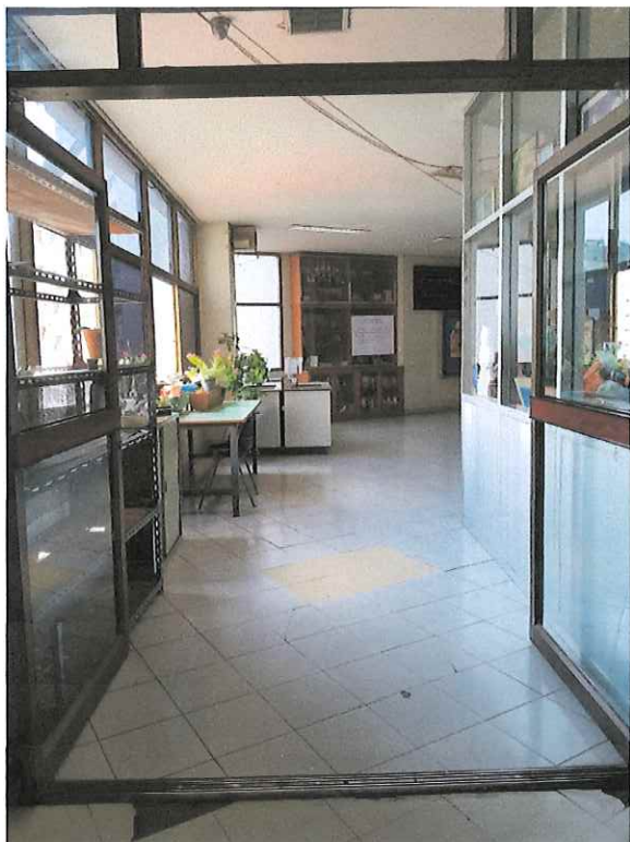
รูปที่ 4 จุดสิ้นสุดการปูกระเบื้องแกรนิตโต้ ขนาด 60x60 ซม. 2
