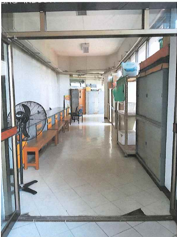
รูปที่ 5 บริเวณโซน B ทางเดินหน้าห้องปฏิบัติการ 713 (รูปที่ 5, 6, 7, 8 มีงานรื้อกระเบื้องยางเดิมและปูกระเบื้อง ยางใหม่, งานทาสีผนัง เพดาน และงานทาสีท่อและราง สายไฟ)
