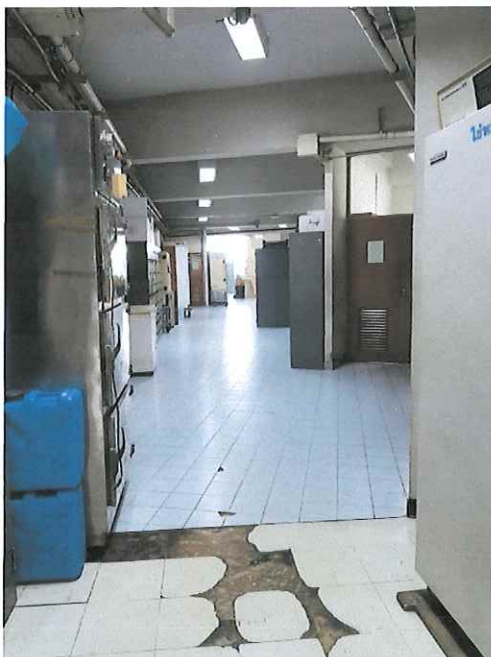
รูปที่ 8 จุดสิ้นสุดการปูกระเบื้องยาง
